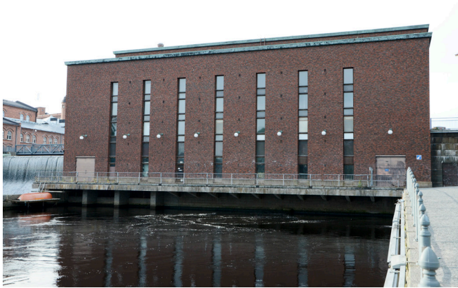
Sähkölaitoksen padon rakennus Koskipuistossa
