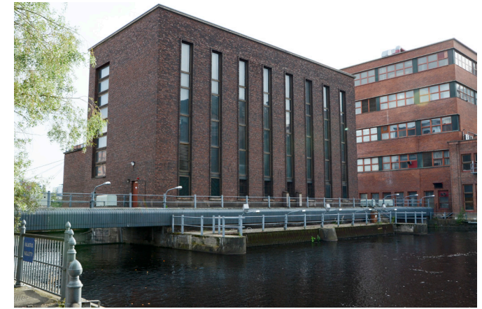
Takon padon voimalarakennus, oiva paikka ravintolalle?
