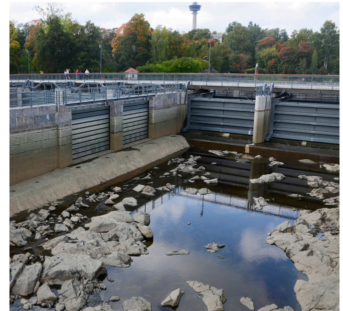
Säilytettävät koskenniskan sulkuportit
