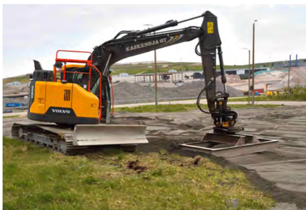
Kivituhkan levittämistä lupiinin kasvustojen päälle kaivinkoneella Ämmässuon ekoteollisuusalueella.
