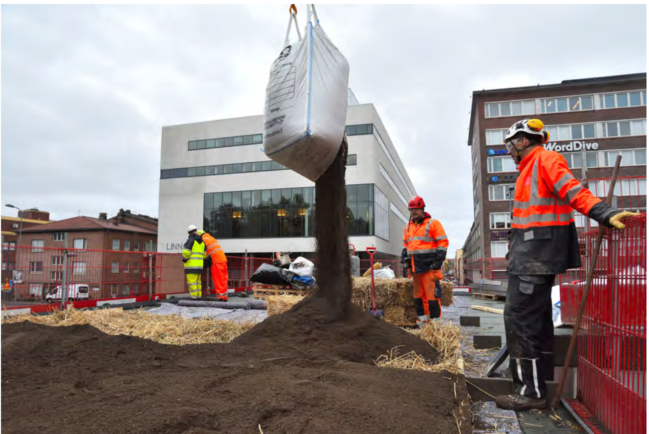
Viherkaton kasvialustan rakentamista Tampereen yliopistolla. Kasvialusta on valmistettu kierrätysmateriaaleista ja sivuvirroista.
