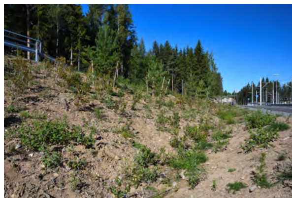
Metsänpohjan hyödyntämistä kasvualustana Tampereella Hallilan raitiotiepysäkin viherrakenteissa.
